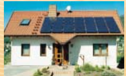
Haus mit Solarmodul
