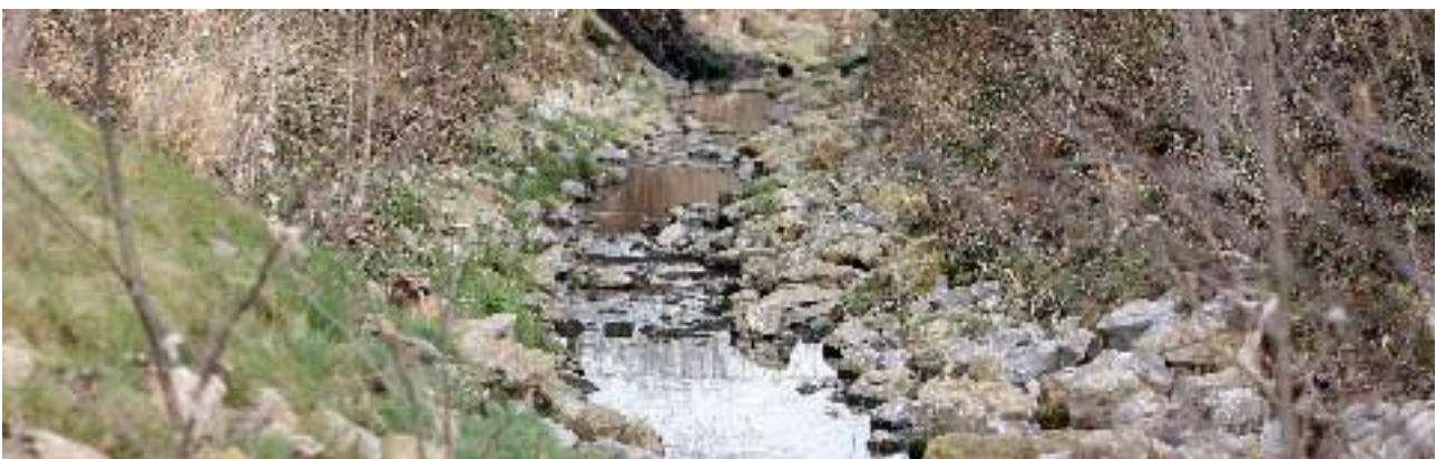
Renaturierung des Feuerbachs vorher/nachher
