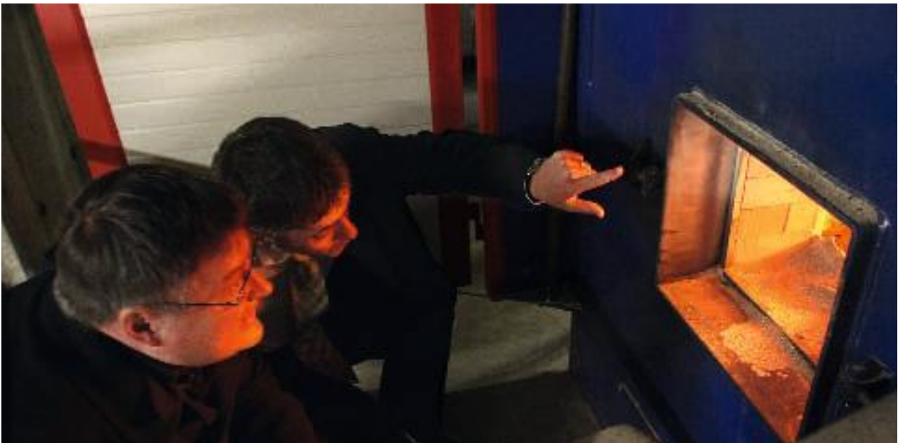
Bürgermeister Matthias Hahn informiert sich über eine Holzheizung zur schonenden Energiegewinnung.
