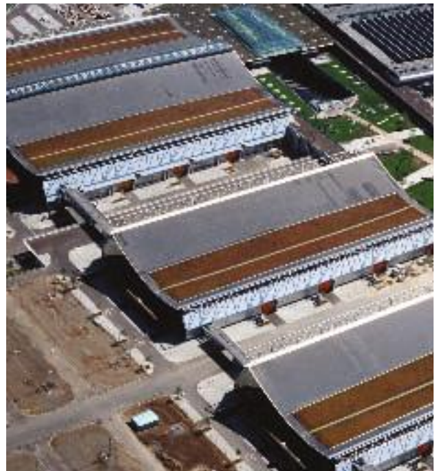
Auf den Dächern der Messe Stuttgart wird in 2009 eine Photovoltaikanlage installiert.
