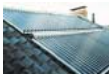
Röhrenkollektoren
