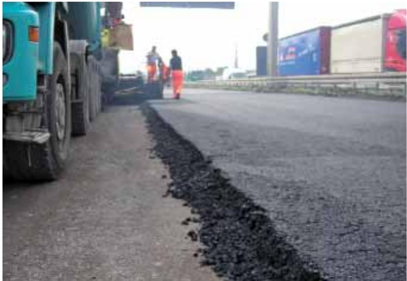
*Ein lärmoptimierter Splittmastixasphalt kann bis zu 5 dB(A) leiser sein als ein herkömmlicher Asphaltbelag*
