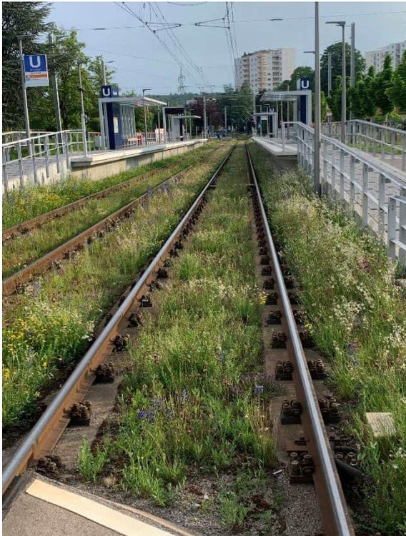
*Abbildung 65: Rasenbahnkörper bei Stadtbahn-Haltestelle Lapp Kabel, © LHS*
