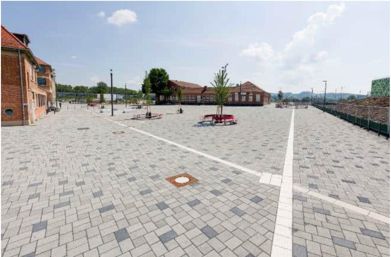
*Abbildung 25: Sickerpflaster Marga-von-Etzdorf-Platz, ©LHS*
